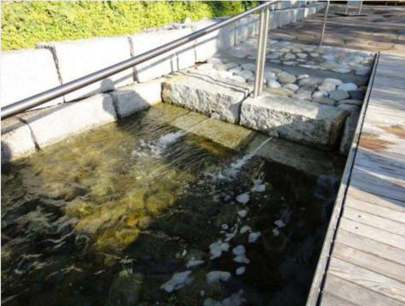
Düsen reinigen die Stiegen; die Stiegen sind erst recht glitschig → Biofilmwachstum durch Nährstoffanlieferung durch Strömung
